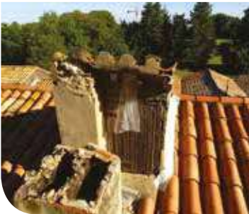
Dispositif anti-retour de type chaussette.
