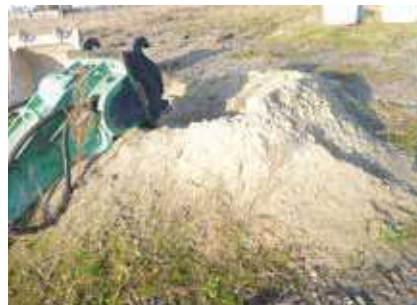
Tas de sable créé sur le chantier.
