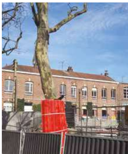
Protection d'un arbre sur le chantier.
