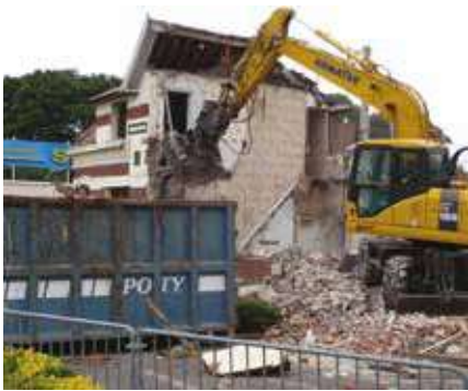
Chantier de déconstruction.
