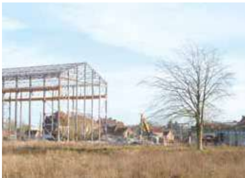
Hêtre maintenu après la déconstruction.
