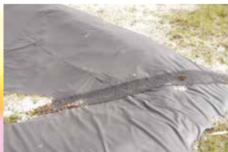
Rampe pour vertébrés, bassin tamponnement.
