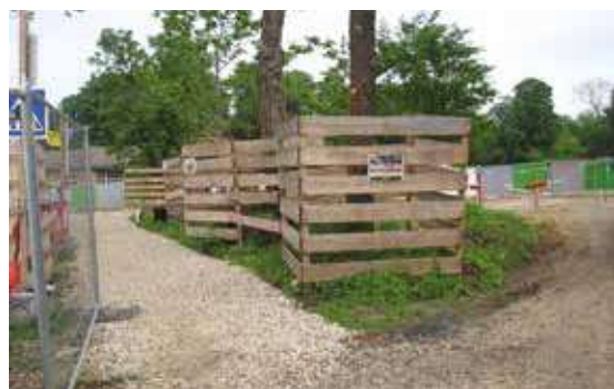
Balisage du chantier.
