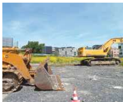
Gestion du parking des engins de chantier.
