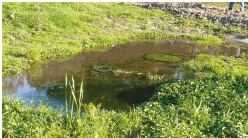
Mare sur un chantier.
