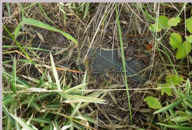
Présence d'une bâche plastique au sol. Elle peut limiter la capacité de ce dernier à infiltrer l'eau de pluie. / Margot Dedieu, Plante & Cité
