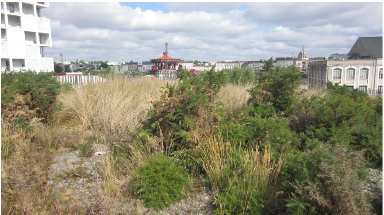
Toit végétalisé de l'école Aimé Césaire, sur l'île de Nantes (44). Lors de sa construction en 2012, un toit végétalisé a été mis en place sur cette école. Deux types de végétation, de type dune et lande, ont été implantés. Trois ans plus tard, douze espèces d'abeilles y ont été détectées, dont une espèce d'abeille-coucou, Coelioxys conoidea , et une espèce peu commune en France, Lasiglossum leucopus . Photo : Olivier Lambert.
